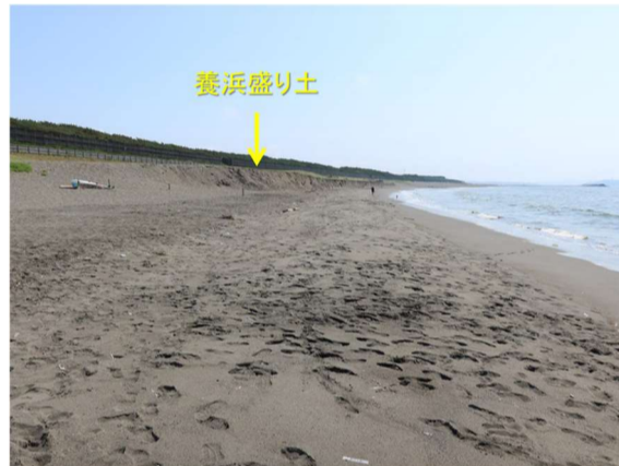
【砂が堆積してバームが形成】
