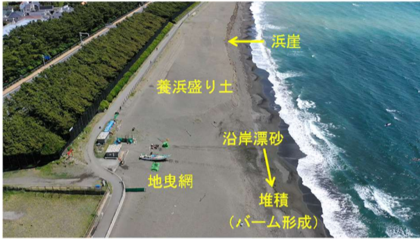
【中海岸地区での養浜盛り土の西端部】
