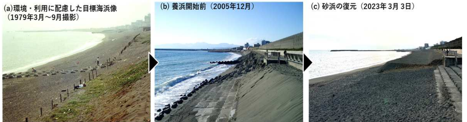
図3 環境・利用に配慮した目標海浜像と養浜開始前と現在の砂浜（中海岸地区）
