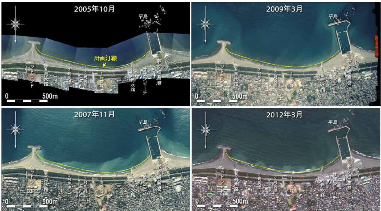
図-10 空中写真による海岸の経年変化 (2005年10月～2012年3月)
