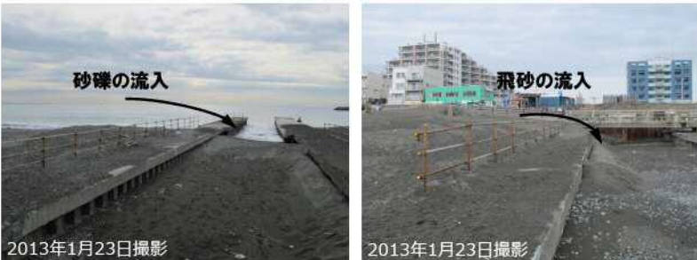
図-47 6号水路東側での大量の礫の堆積状況 (一部天端を越えて水路内へ堆積)
