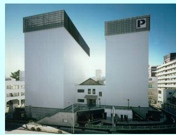
小田原市栄町駐車場
