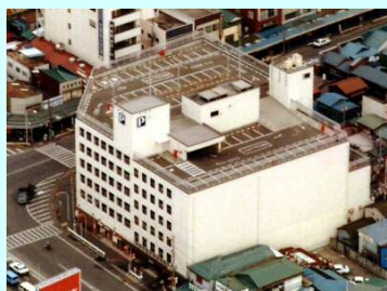
平塚市紅谷町立体駐車場
