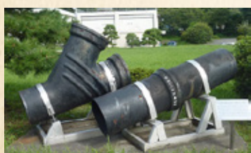
昭和16年に布設された水道管
