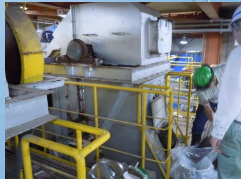
焼却施設における焼却灰のサンプリング
