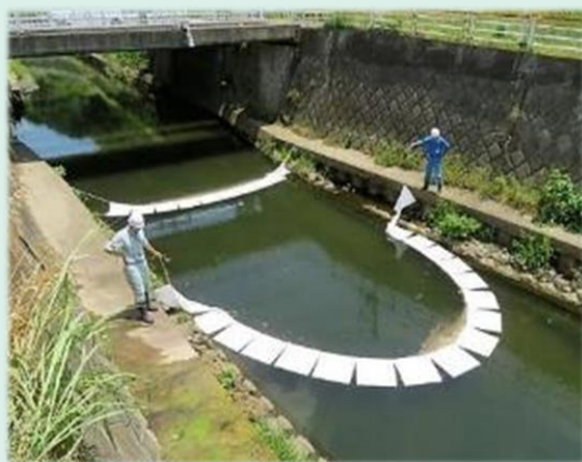
油を吸着するオイルマットの設置
