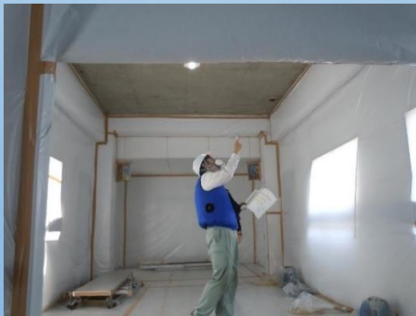
アスベスト(石綿)の養生検査
