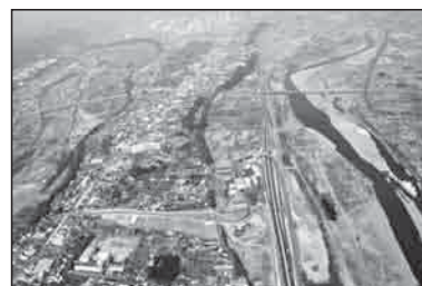
さがみ縦貫道路 （圏央厚木インターチェンジ）
