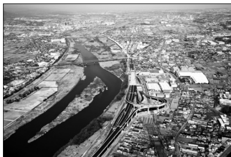
▲ さがみ縦貫道路（寒川北インターチェンジ）
