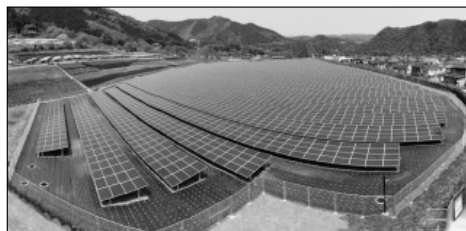
▲ 愛川太陽光発電所
