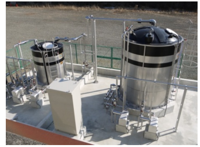
凝集剤添加設備
