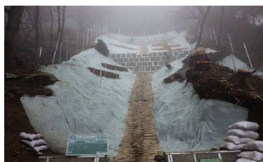
水源林の基盤整備
