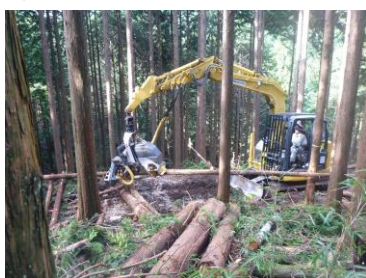
高性能林業機械を利用した 搬出作業の様子
