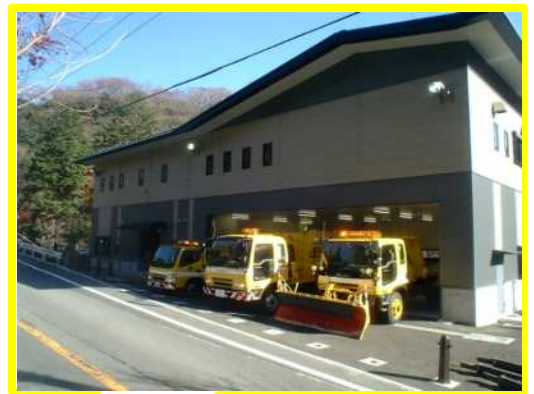
木賀基地 (H16.3 完成)
