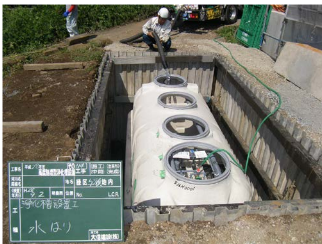
長屋への浄化槽設置(10人槽)
