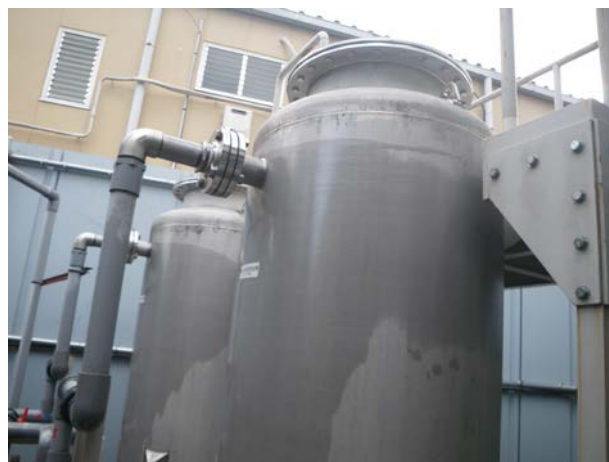
地下水汚染対策（秦野市 浄化施設）
