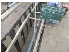
開削工法による下水道管の敷設
