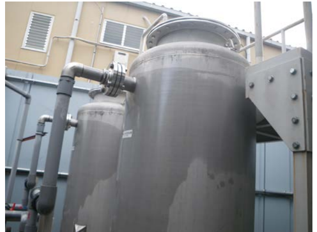
地下水汚染対策（秦野市 浄化施設）
