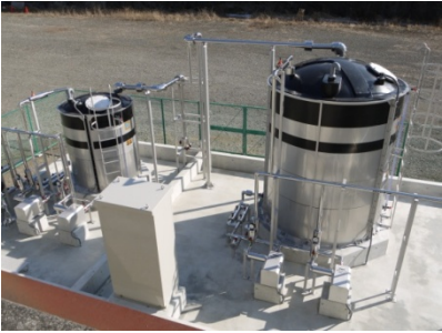
凝集剤添加設備
