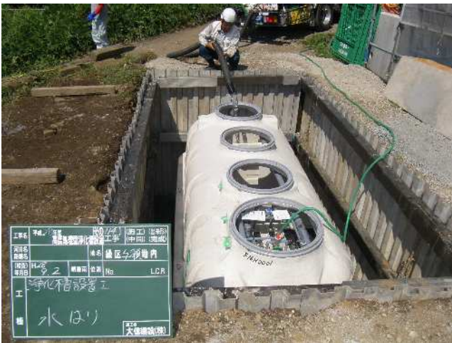
長屋への浄化槽設置(10人槽)
