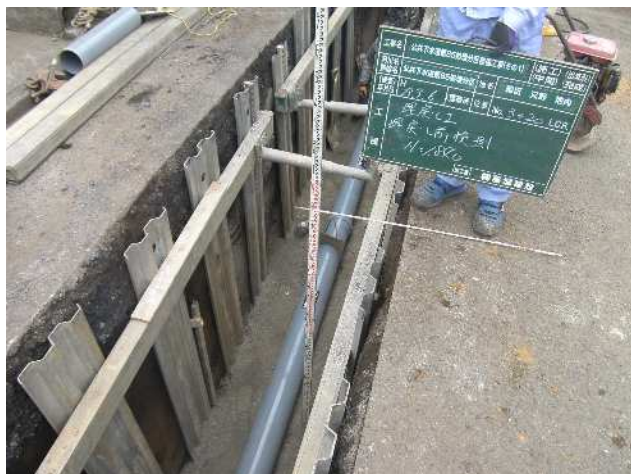
開削工法による下水道管の敷設
