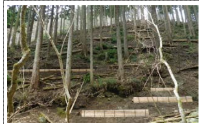
③溪畔林整備 土壌流出が発生している、あるいは発生しそうな箇所に土壌保全工を実施した。(山北町笹子沢)
