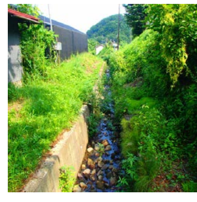
⑥河川・水路における自然浄化対策 ・伊勢原市藤野用水路での整備事例 ・河床に自然石を配置することで、礫間浄化を促進させるよう整備した。 ・その後、自然の土砂堆積や、植物が生えることにより、整備前に生息していなかった種が見つかるなど生物の生息空間が確保された河川・水路となった。
