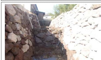
⑥河川・水路における自然浄化対策 自然石による護岸とし、礫間浄化を促進させた。(伊勢原市藤野用水路)
