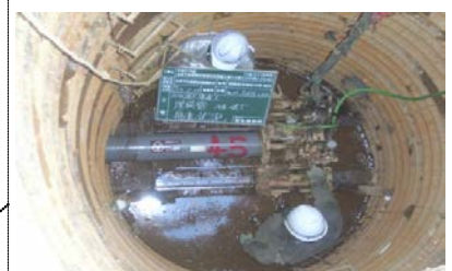
⑧⑨ダム集水域の生活排水対策(下水道・浄化槽) 推進工法(道路を開削せず、トンネル上に掘削した穴に管を通す工法)により管を敷設した。(相模原市緑区)
