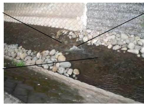
落差があると水中の動植物に必要な酸素が供給できる（落差は生物の移動の妨げにならないようにする。）。
