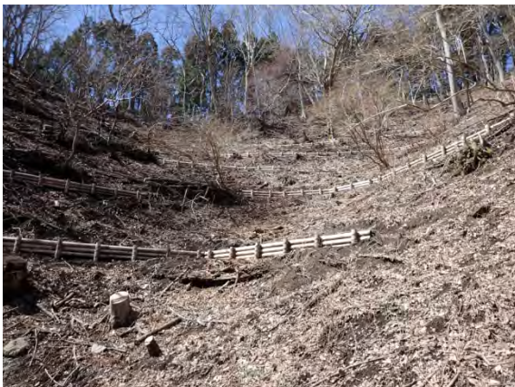
広葉樹整備における土壌保全工実施状況（写真左が丸太筋工、右が丸太積工）
