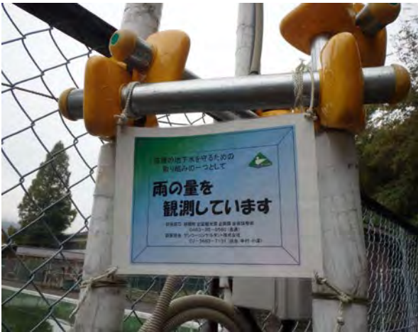
箱根町の地下水モニタリング事業
