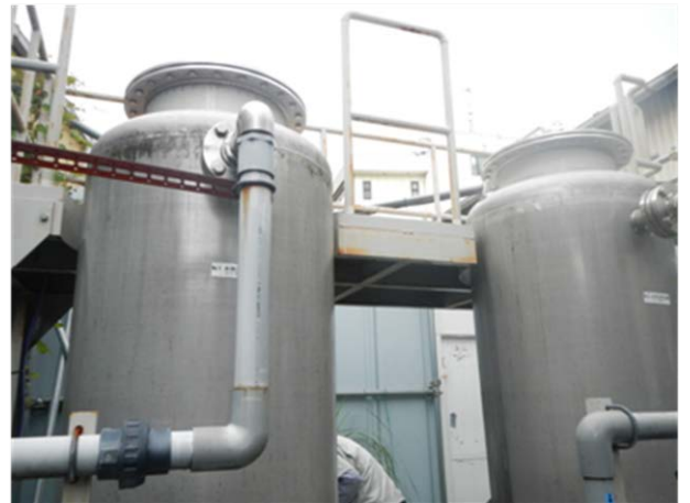
地下水汚染対策（秦野市 浄化施設）
