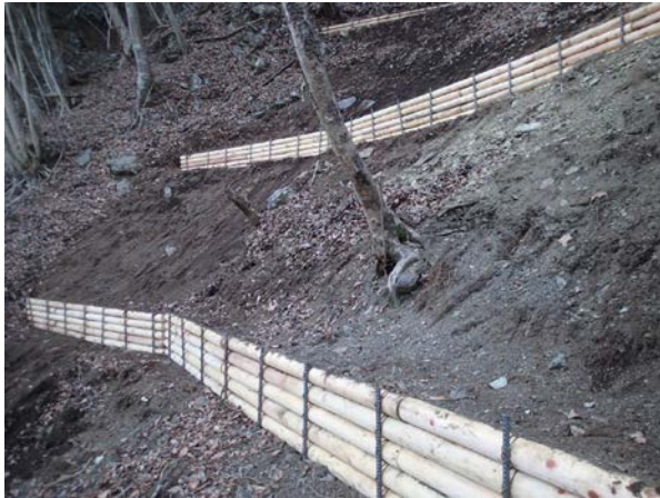
広葉樹整備における土壌保全工実施状況（写真左が丸太柵工、右が金網筋工）
