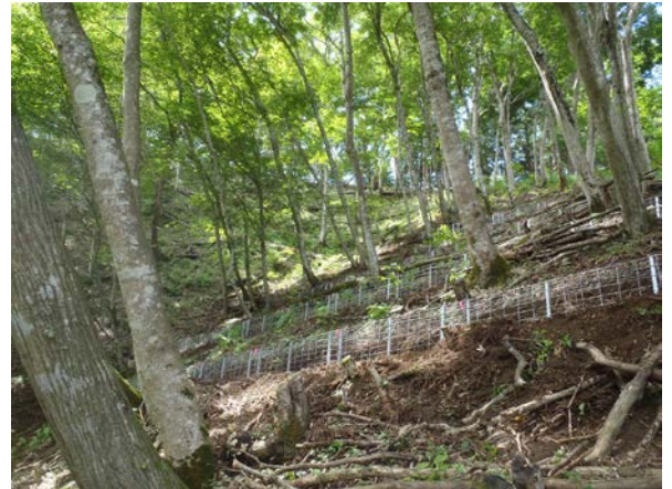
広葉樹整備における土壌保全工実施状況（写真左が丸太柵工、右が金網筋工）
