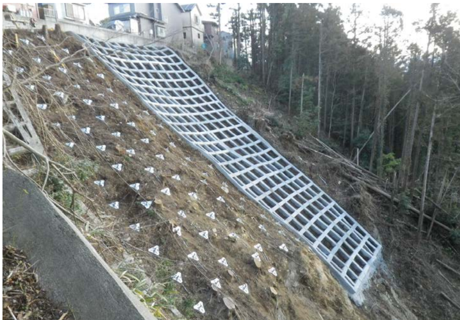
治山事業実施後
