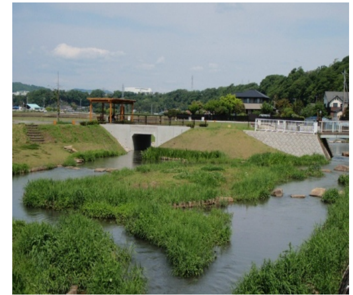
【厚木市：善明川(整備後)】
