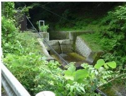
森林モニタリング（対照流域法）のため、新たに整備した流量を観測する施設。
