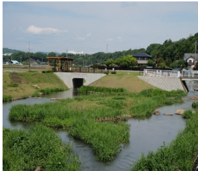
【厚木市:善明川(整備後)】
