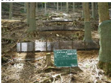
間伐により林内を明るくするとともに、土壌流出を抑える金網柵を設置した。(③溪畔林整備：山北町白石沢)
