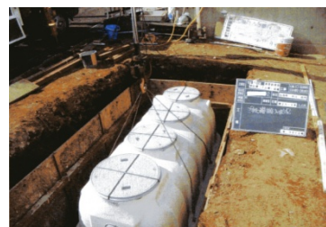
合併処理浄化槽(7人槽)の整備により、水質改善を図った。(⑧⑨ダム集水域の生活排水対策(下水道・浄化槽)：山北町中川)
