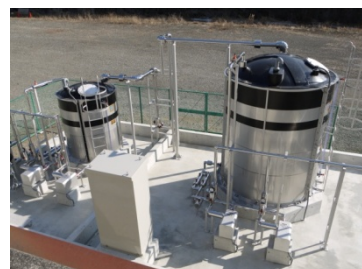
山梨県内の下水処理場に、リンを取り除くための設備を新たに設置した。(⑩相模川水系上流域対策：山梨県桂川清流センター)
