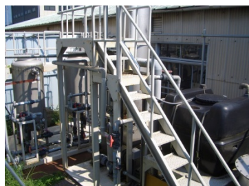
有機塩素系化学物質により汚染された地下水を、浄化装置を通すことにより水質浄化を図った。(⑦地下水保全対策：秦野市)
