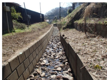
川底に礫(れき)を敷くことで、自然浄化機能を高める取組。(⑥河川・水路における自然浄化対策：伊勢原市藤野用排水路)
