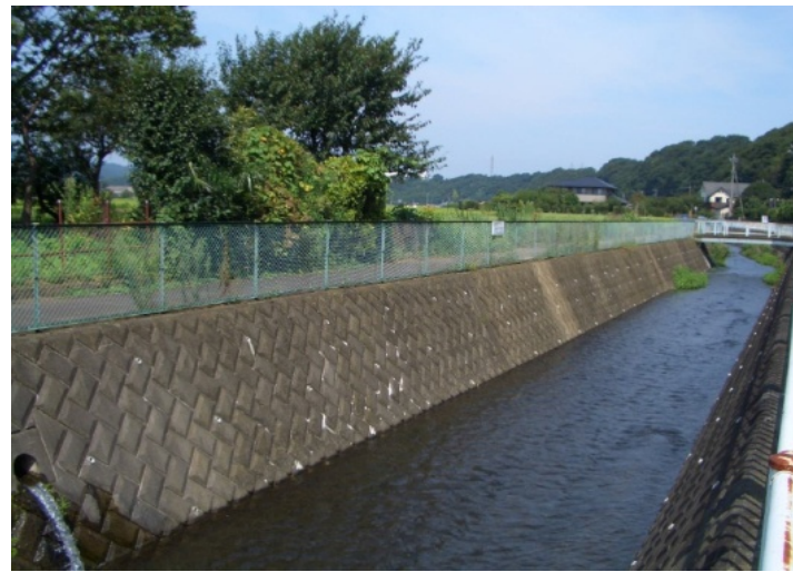
【厚木市:善明川(整備前)】
