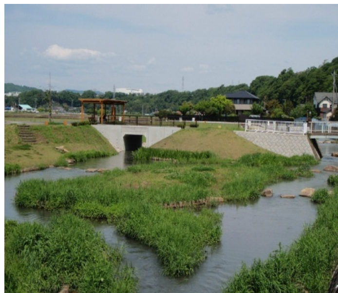
【厚木市:善明川(整備後)】
