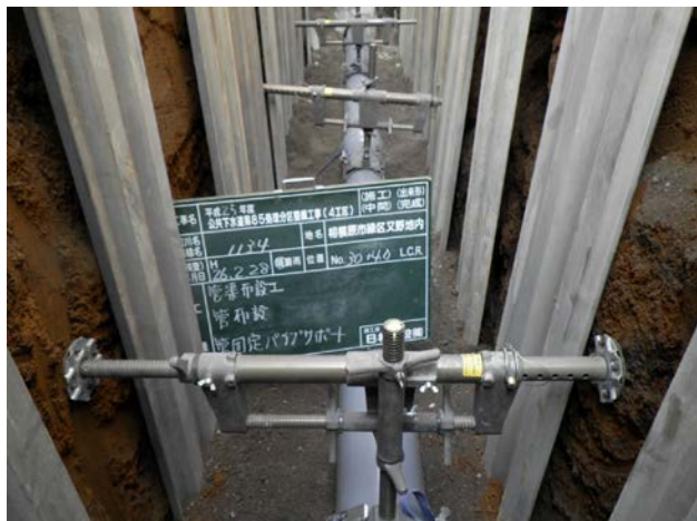
開削工法による下水道管の敷設
