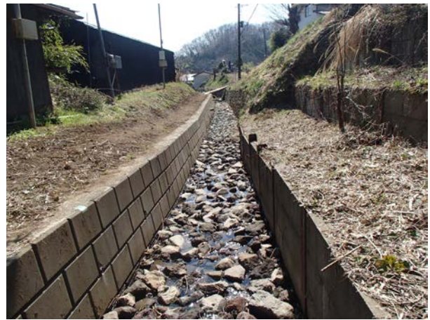
〈整備後〉河床に礫を敷くことで、礫間浄化を促進させた。
