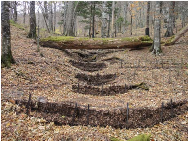
土壌保全対策工事（清川村 丹沢山東側山腹）
