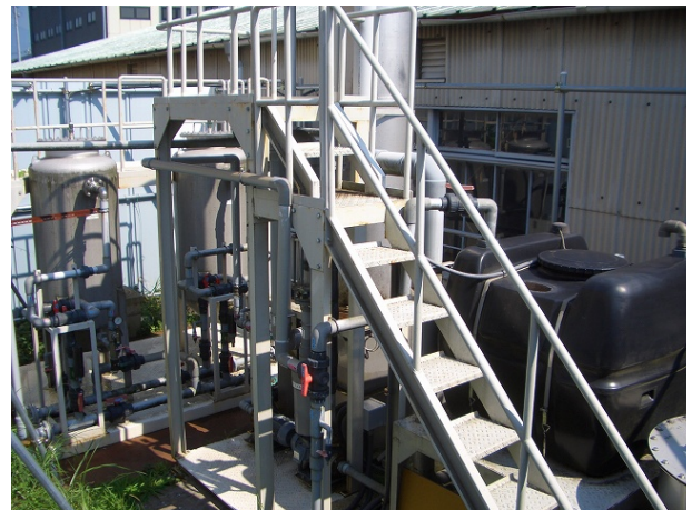
地下水汚染対策(秦野市 浄化施設)
