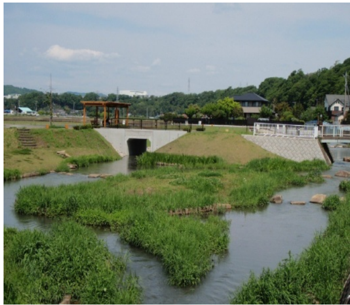
【厚木市:善明川(整備後)】
