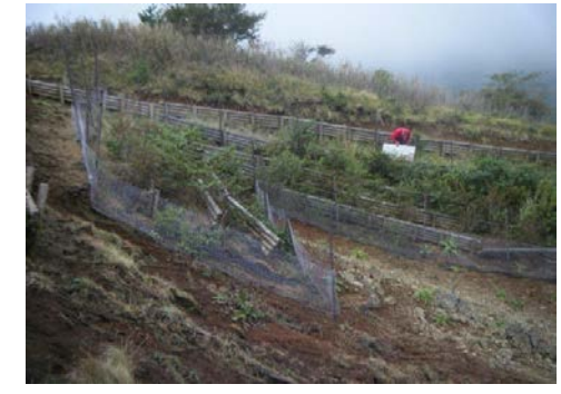
【写真(埋設ゴミ処理後の緑化イメージ)】
