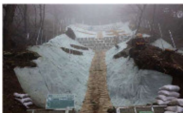
水源林の 基盤整備
