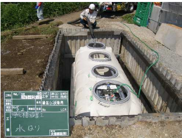
長屋への浄化槽設置(10人槽)
