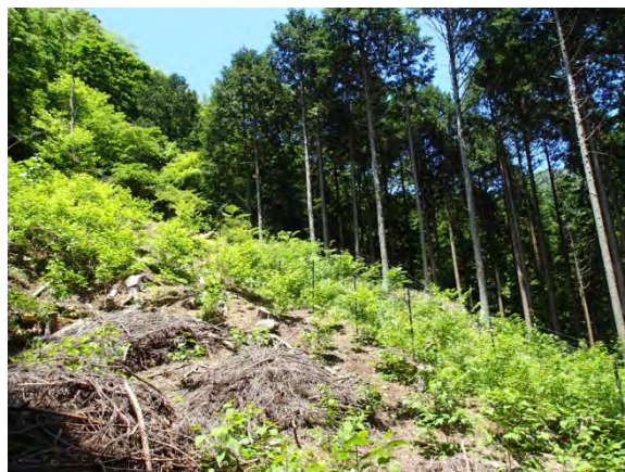
【施工後】（平成 28 年 6 月撮影）
