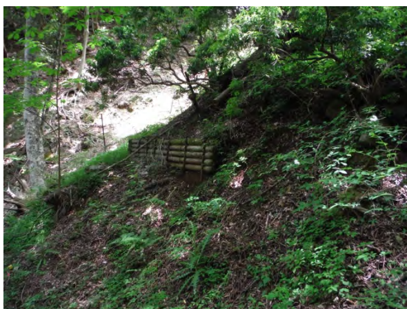
土壌保全工設置箇所（本谷川）
