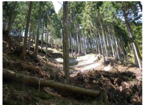
写真13：丸太筋工設置箇所（大滝沢）
