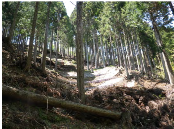
丸太筋工設置箇所（大滝沢）
