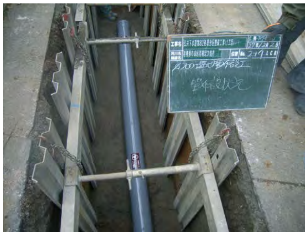
開削工法による下水道管の敷設
