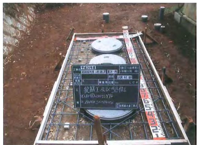
一般家庭への浄化槽設置（5人槽）
