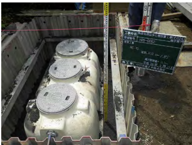
団地集会所への浄化槽設置（5人槽）
