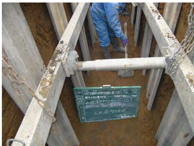
開削工法による下水道管の敷設
