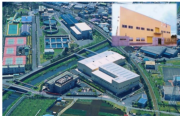
【寒川浄水場排水処理施設】
