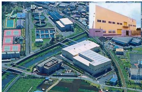
【寒川浄水場排水処理施設】
