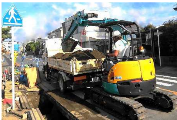
【水道管埋設状況】
