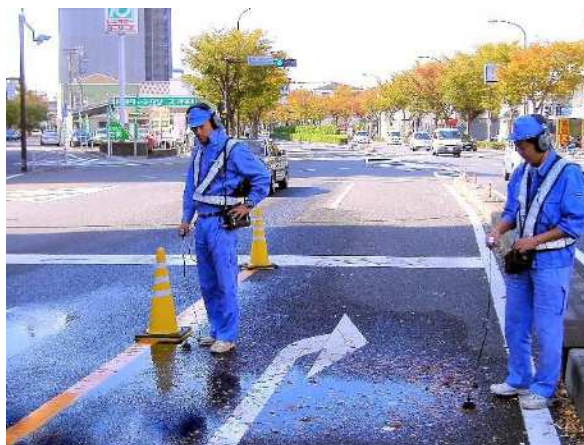
【漏水調査の様子】
