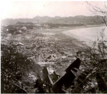
大正関東地震による鎌倉海岸由比ガ浜の津波被害
