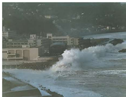
湯河原で発生した高潮・高波(H9.6)
