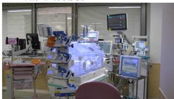
NICU 内部（一部改修後）
