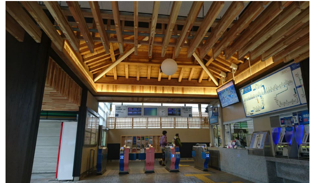
【内装木質化の例(小田急小田原線鶴巻温泉駅)】
