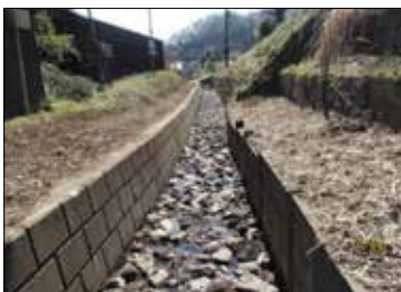
⑥河川・水路における自然浄化対策 川底に礫(れき)を敷くことで、自然浄化機能を高める整備を実施した。(伊勢原市藤野用排水路)
