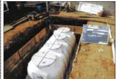
⑧⑨ダム集水域の生活排水対策(下水道・浄化槽) 窒素・リンを除去できる高度処理型合併処理浄化槽(7人槽)(山北町中川)への転換を図った。
