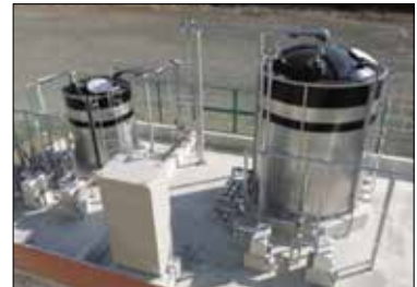
⑩相模川水系上流域対策 山梨県内の下水処理場に、リンを取り除くための設備を新たに設置した。(山梨県桂川清流センター)
