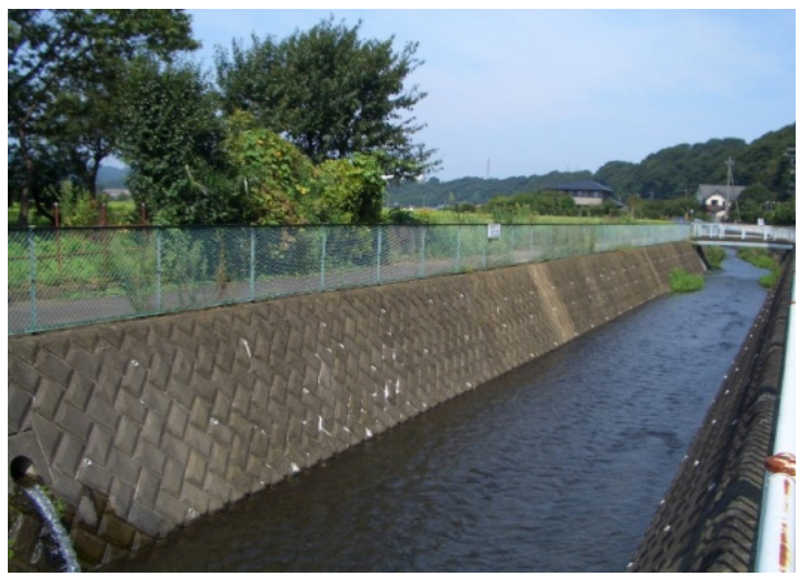
【厚木市：善明川(整備前)】
