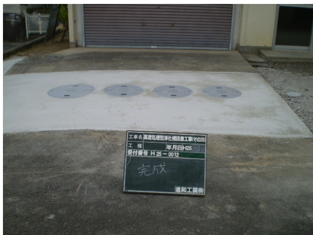
団地集会所への浄化槽設置（7人槽）
