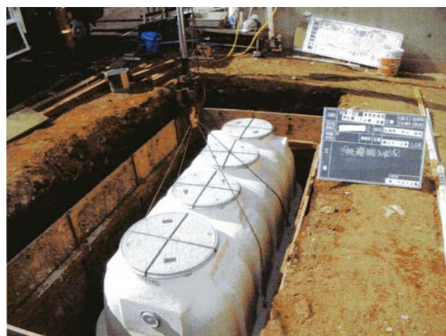
一般家庭への浄化槽設置（7人槽）
