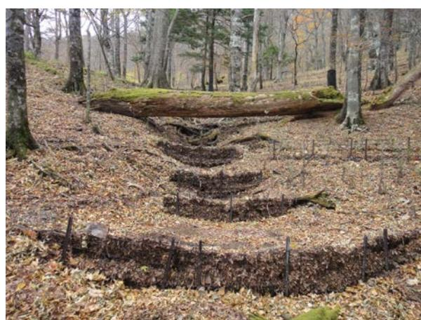
土壤保全対策工事で設置した金網筋工の設置後 5 年の状況。侵食箇所に落葉落枝が堆積し、森林土壤の流失を抑えている状況がうかがえる。
