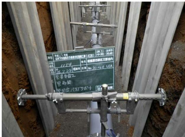
開削工法による下水道管の敷設
