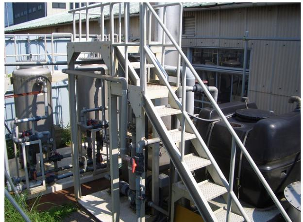
有機塩素系化学物質により汚染された地下水を施設の装置に通すことにより浄化を図る。
