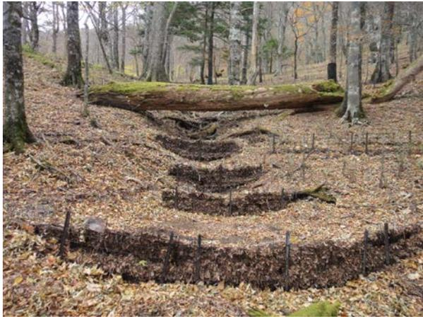
土壌保全対策工事で設置した金網筋工の設置後 5 年の状況。侵食箇所は落葉落枝が堆積し、森林土壌の流出を抑えている状況がうかがえる。
