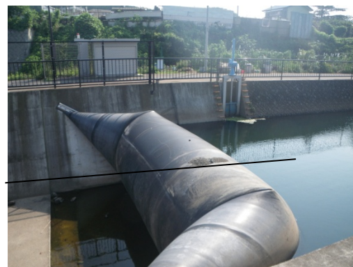
河床に浄化ブロックを設置
