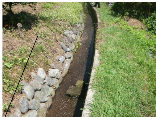
山北町 川村用水路
