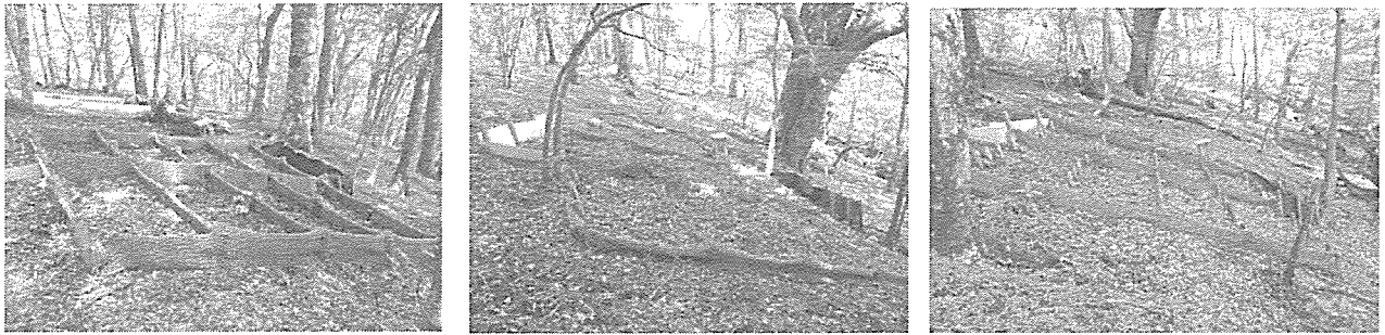
写真 2009 (H21) 年 7 月時点の対策工の状況
