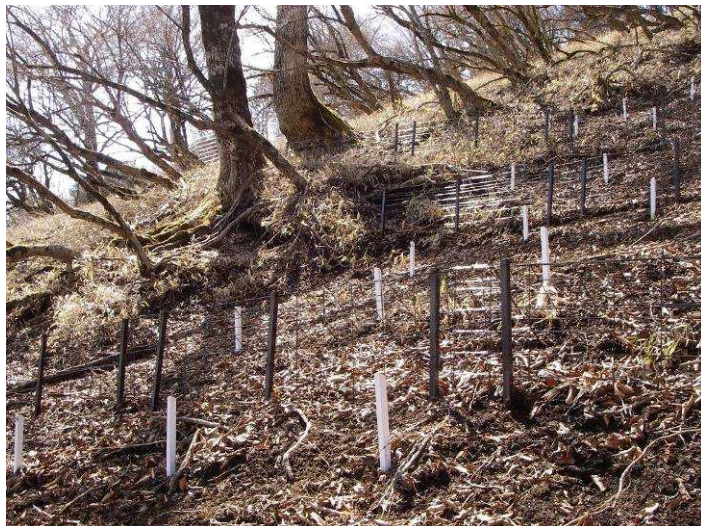
写真 金網筋工（茶色の網の中及び上部に落枝落葉を貯留させて土壌流出防止効果を発揮する施設）施工箇所に設置した土砂移動量調査枠（白色鋼製柱が枠状に設置されている）
