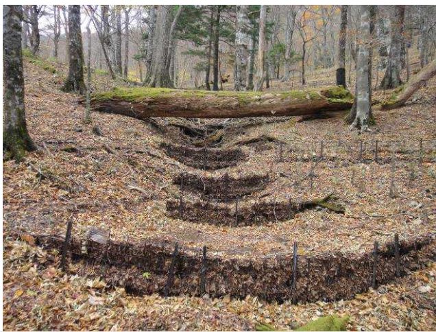
土壌流出防止対策（清川村 丹沢山東側山腹斜面）
