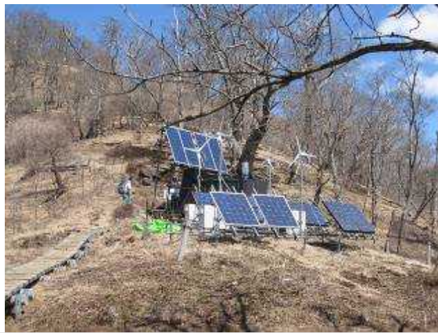
気象・大気環境調査（更新した檜洞丸観測サイト）
