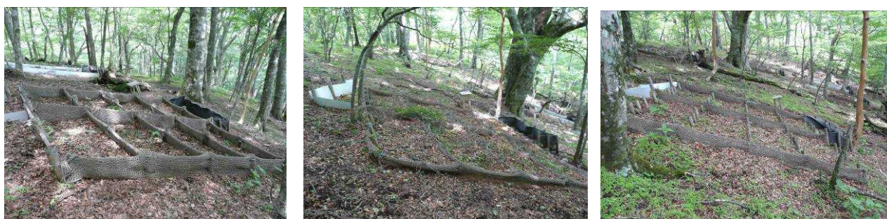
写真 2009 (H21) 年7月時点の対策工の状況
