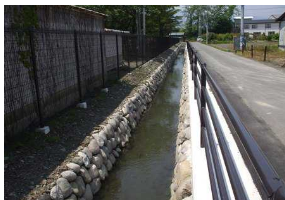
自然石を積んだ護岸の整備
