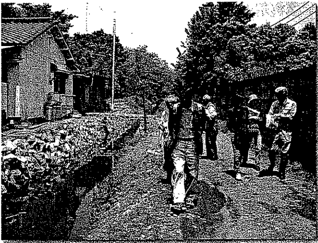
空積護岸等整備現場
