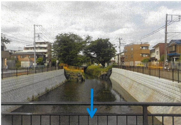
福田7号橋上流
