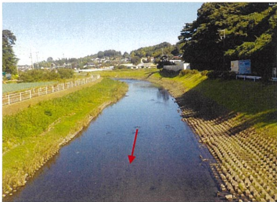
道庵橋上流施工前
